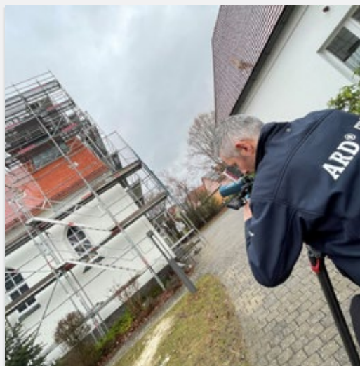
Und auch die Presse dokumentierte die Sanierung der Hirschauer Kirche.
